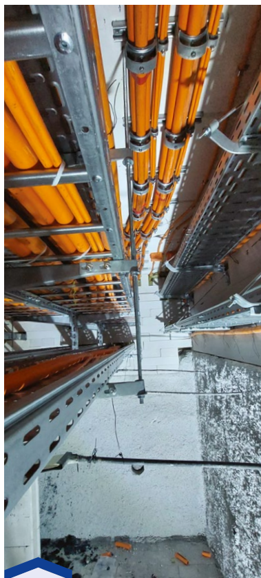
Zespół tras kablowych przed badaniem E90 wg DIN 4102-12
